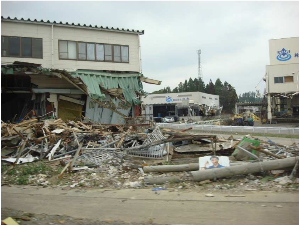
気仙沼市 1階部分は軒並み破壊されている
