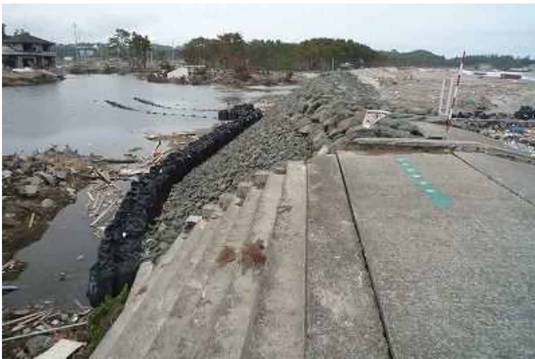
七ヶ浜 破壊された防波堤を応急復旧したところ
