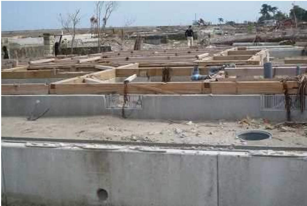
七ヶ浜 防波堤の内側 住宅エリア まだ新しい基礎だけが残る
