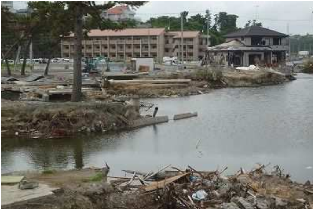
七ヶ浜 津波で防波堤が破壊され陸地が削り取られ、もう水は引きそうもない
