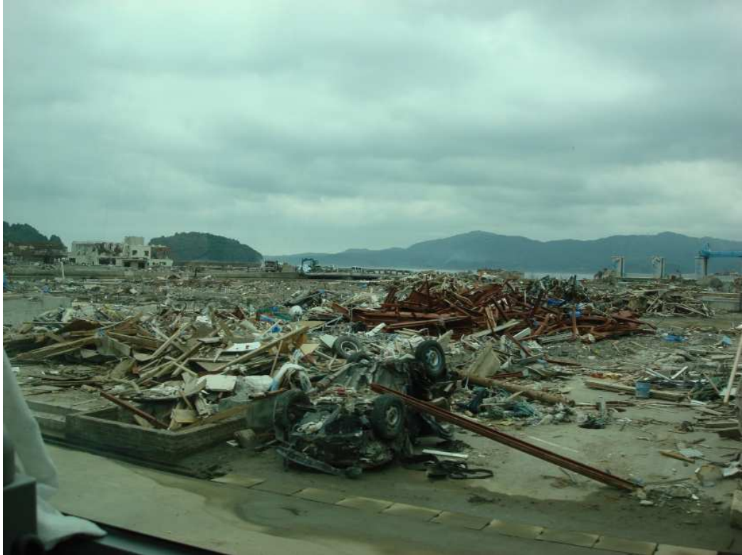
南三陸町 がれき撤去は確実に進んでいるがまだまだです
