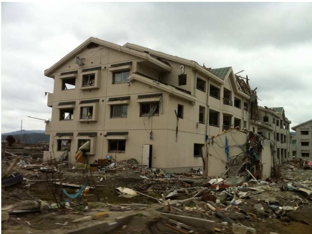
南三陸町 津波は屋根の高さを超えています
